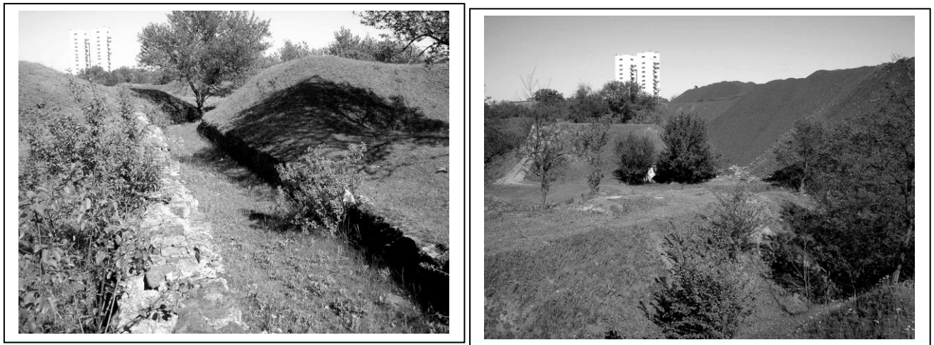
Рис. 2. Гидротехнические объекты РУ им. Р. Люксембург – дренажная система: фото слева – участок сохранившегося канала, справа – арка перепуска дренажных вод (почти засыпана, на фотоснимке – по центру возле деревьев). Фото Казакова В.Л.
